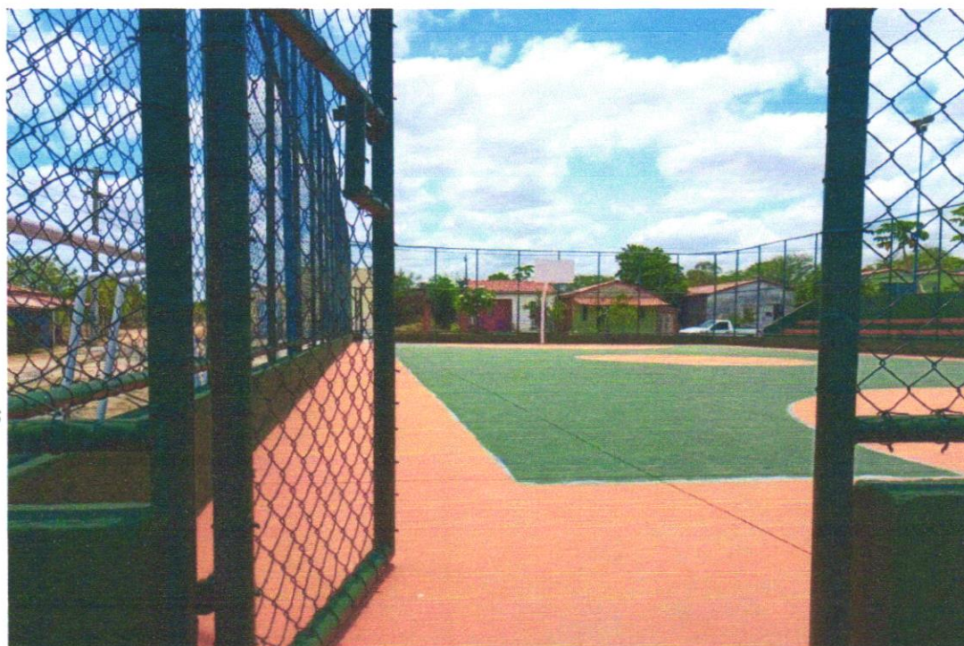
Foto 04- Estrutura metálica fixa, p/ tabela em aço com aro e cesta p/ basquete, padrão oficial, em tubo galvanizado d=5" - instalada
